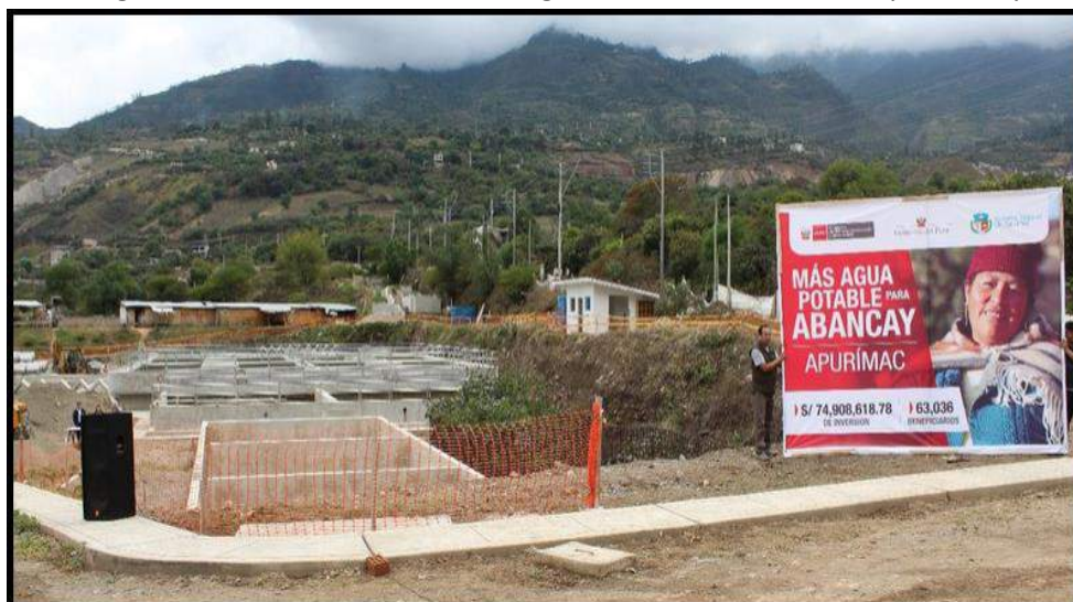
Figura 26 Obra en construcción Lagunas de Oxidación Emusap Abancay
